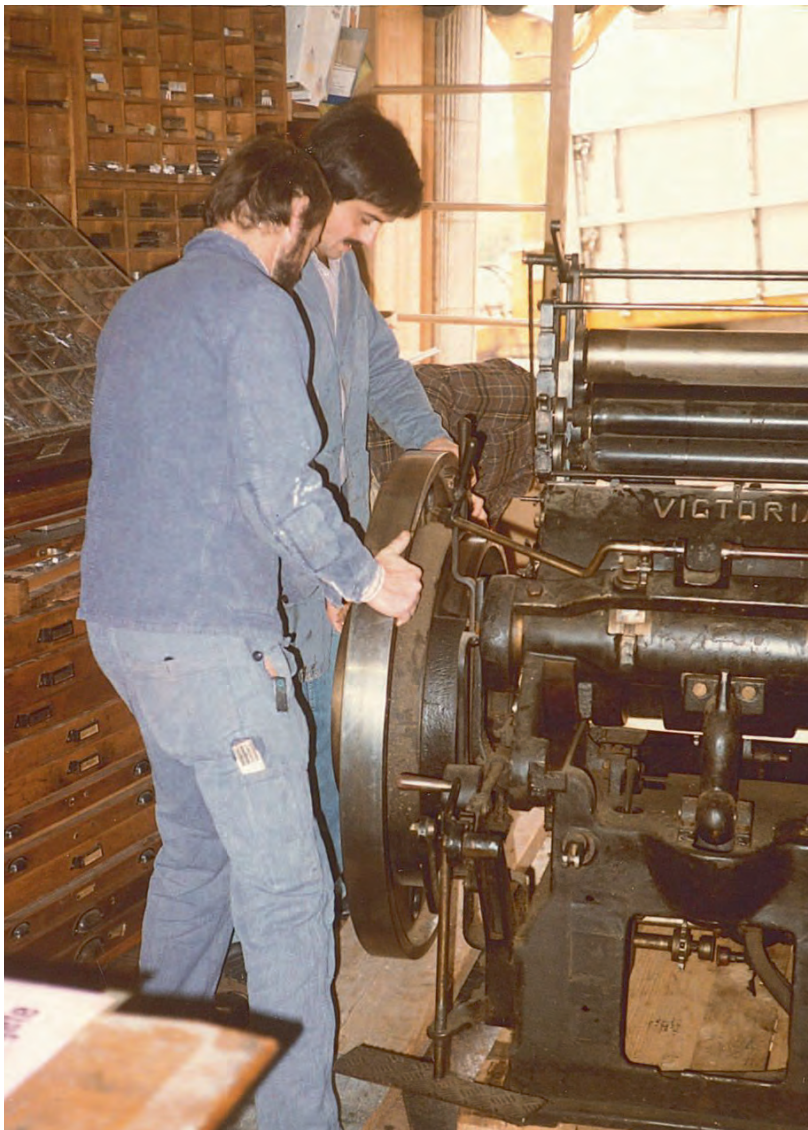
1985 in Feldmeilen: André Golay (rechts) bei der Installation der ersten Druckmaschine der Firmengeschichte. Foto: Archiv Feldner Druck
