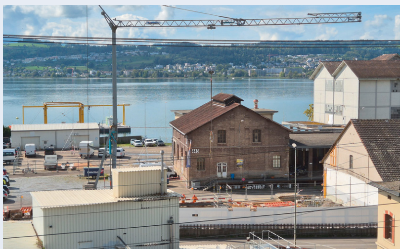
Hinter den Absperrungen verbirgt sich die Baugrube.
