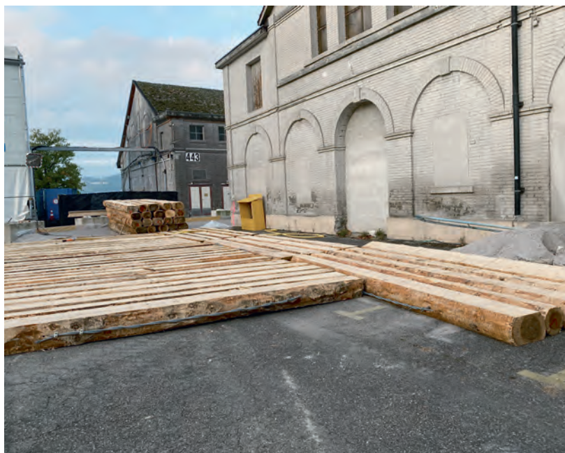
Sicherheitsmassnahmen: Holzbohlen werden beim Abbruch zur Stabilisierung der Wände eingesetzt. Foto: Jérôme Stern
