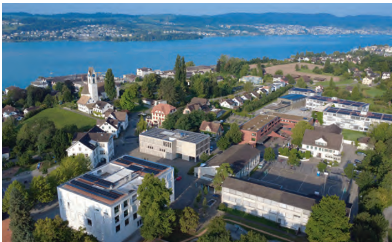
Solarstrom vom Dach: Die Photovoltaikanlage auf dem Schulhaus Mitte produziert einen Grossteil des hauseigenen Strombedarfs. Foto: Jérôme Stern
