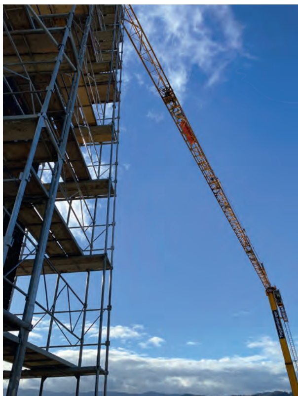
Hier geht es weit rauf: Über das Gerüst um den Kamin gelangen schwindelfreie Arbeiter in 34 Meter Höhe.
