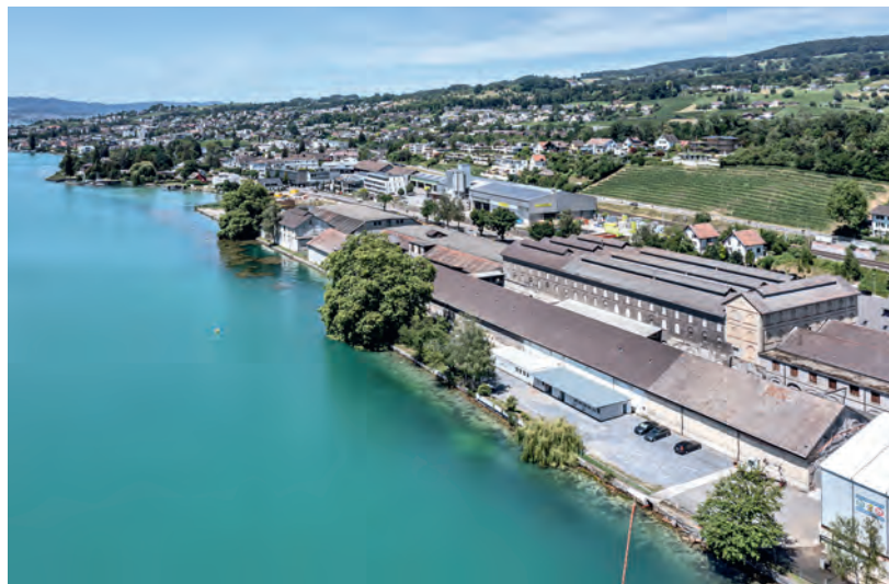
Sünden der Vergangenheit: Auf dem CU-Areal wurde jahrzehntelang bedenkenlos Abfall zur Aufschüttung verwendet.
