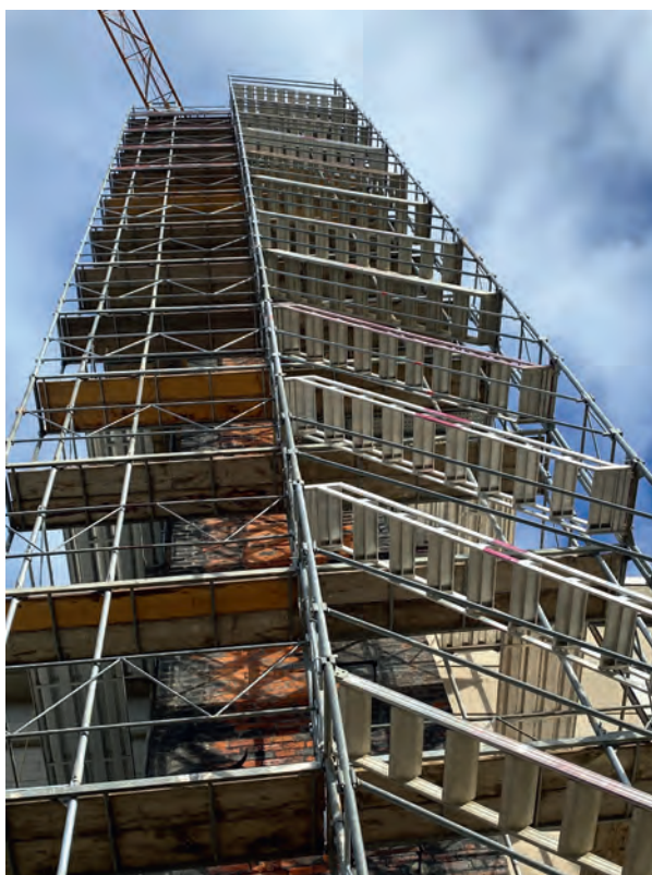
Hier geht es weit rauf: Über das Gerüst um den Kamin gelangen schwindelfreie Arbeiter in 34 Meter Höhe.
