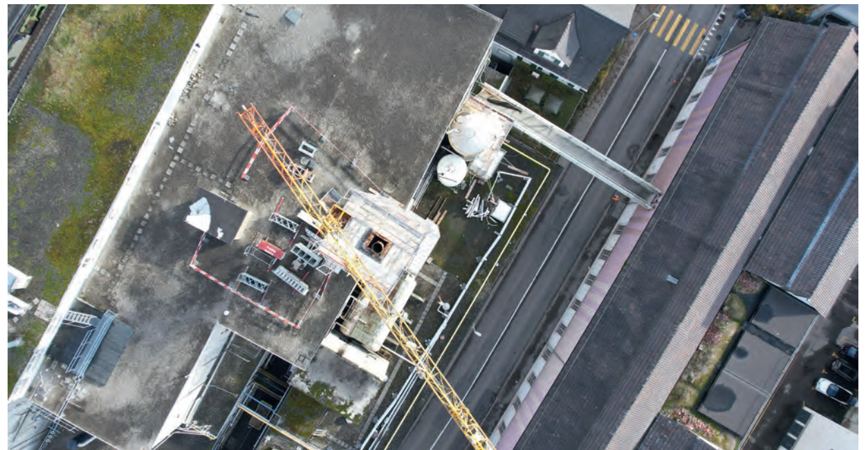
Spezialkonstruktion: Das Gerüst steht auf dem Flachdach neben dem Kamin.
