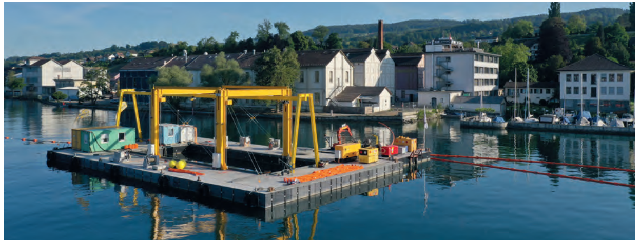
Seit November 2021 wird der Seegrund saniert.
