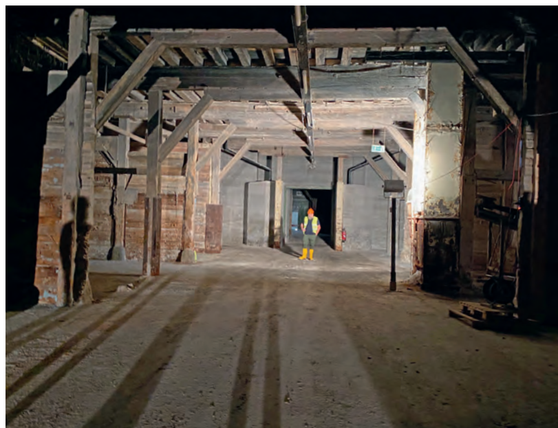
Grosse Räume: Der Düngerbau erstreckt sich über eine Riesenfläche und über drei Stockwerke. Foto: Jérôme Stern
